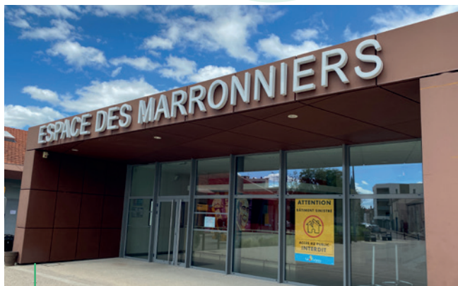
ÉQUIPEMENT. L'Espace des Marronniers a subi de gros dégâts à l'intérieur
