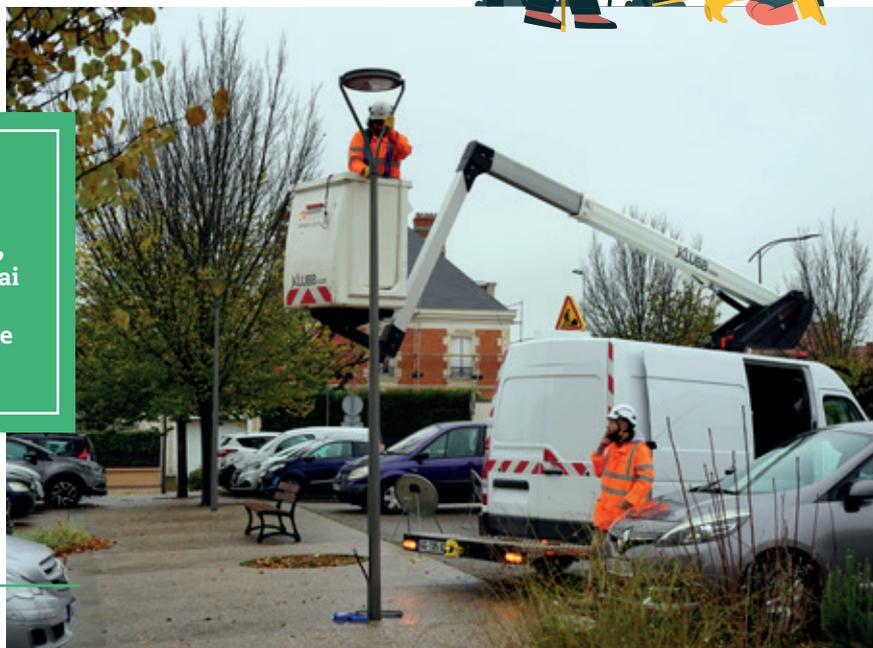
PLACE AUCEY. Remplacement des crosses d'éclairage et passage au Led
