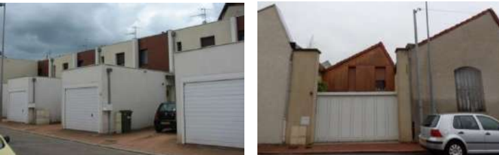
Individuels groupés ZAC de Pincourt/ réhabilitation d'anciens bâtiments industriels en shed pour des
