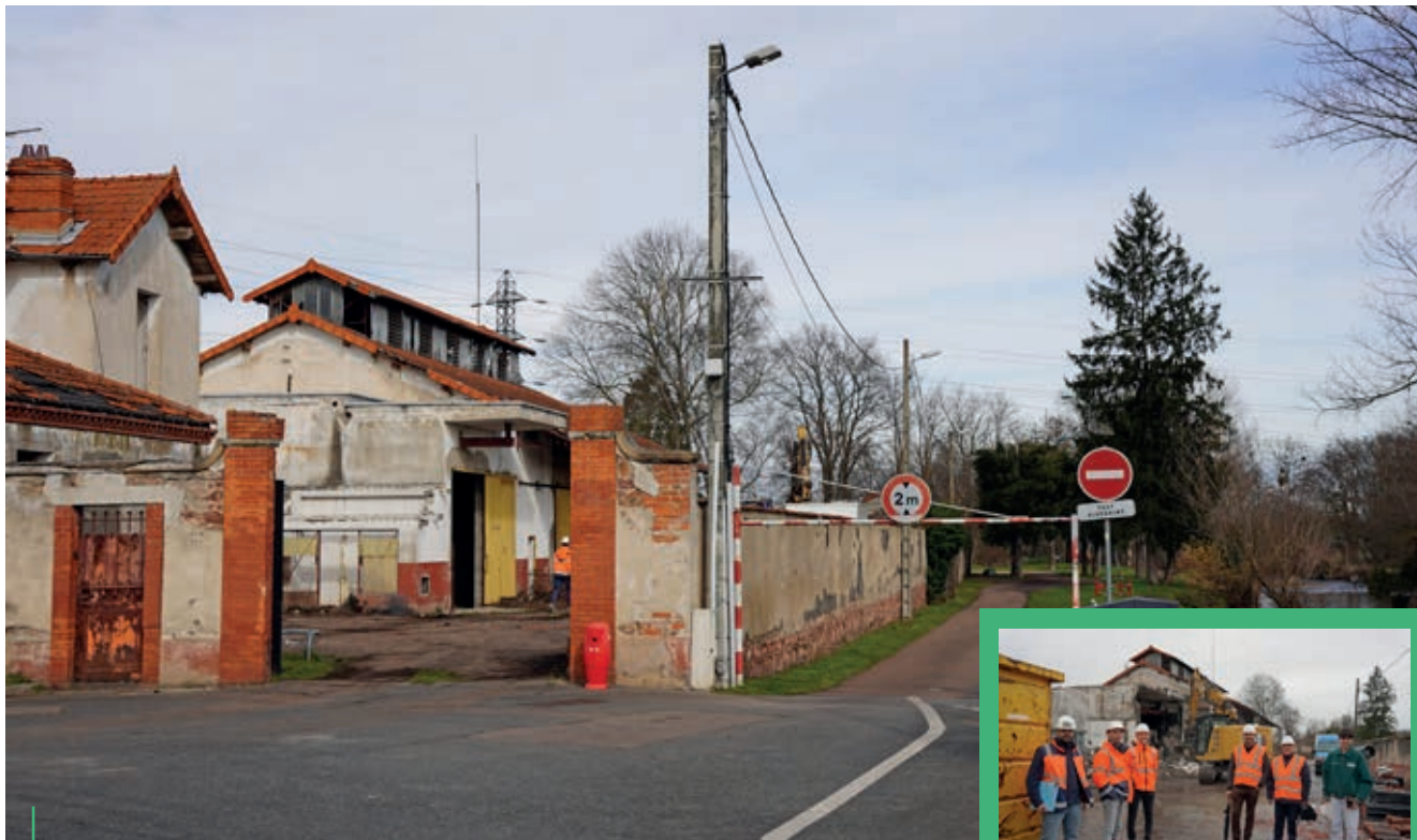
DÉMOLITION. L'ancien abattoir en bord de Rhins
